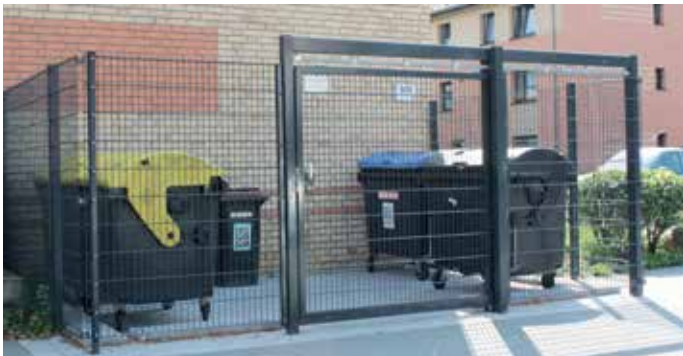
Zutritt nur für berechnigte Mieter stellen abschließbare Müllplätze sicher – wie hier in der Eiderstraße
